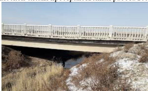
Рис. 4. Железобетонный автодорожный балочный мост
