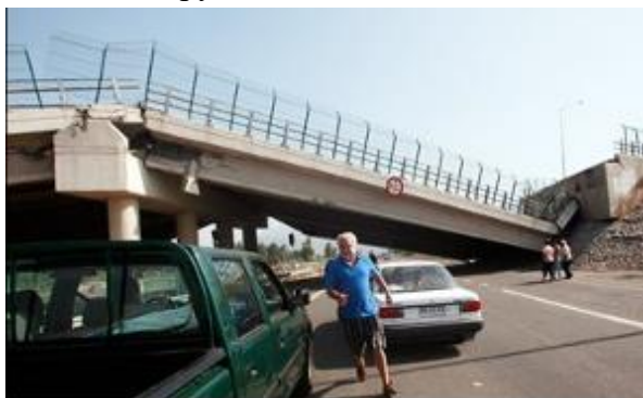
Рис. 1. Разрушение путепровода при землетрясении в Чили
