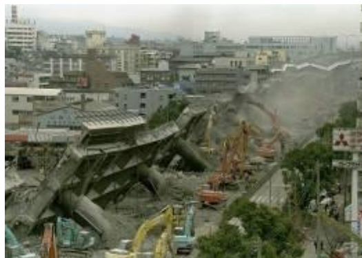
Рис. 2. Разрушение транспортной эстакады при землетрясении в Кобе (Япония)
