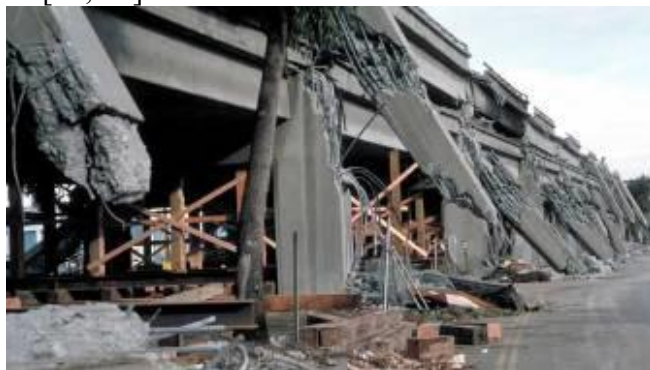
Рис. 3. Разрушенные столбы опор и обрушение виадука на Сайпресс-стрит (землетрясение в Лома-Приета)
